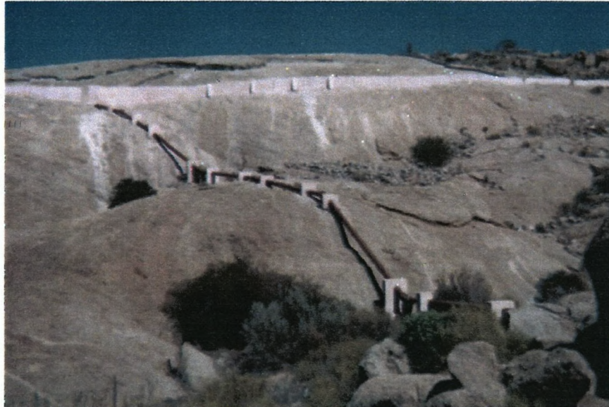
FIGUUR 3.1 - Die muur op die granietkoepel
