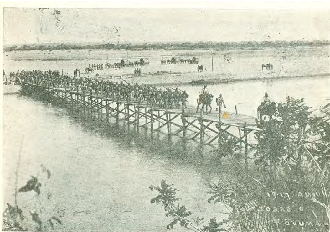
Ponte de cavaletes construída pela engenharia após a passagem do Rovuma
